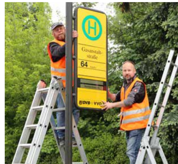
Gunter (links) und Nico Hauswald montieren an der Haltestelle „Gasanstaltstraße“ eine weitere elektronische Abfahrtstafel mit stromsparender LCD-Anzeige.
