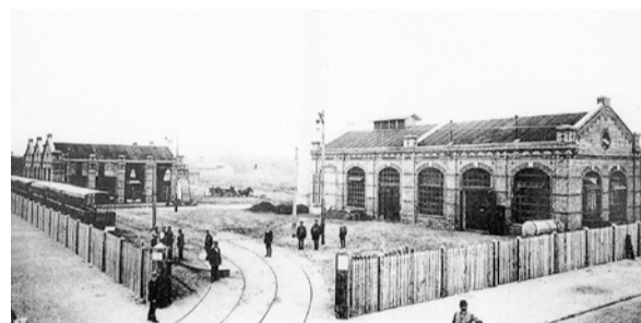
Blick auf den „Betriebsbahnhof“ für elektrisch angetriebene Straßenbahnen an der Hertelstraße. Links der Wagenschuppen, rechts das dampfbetriebene Kraftwerk.
