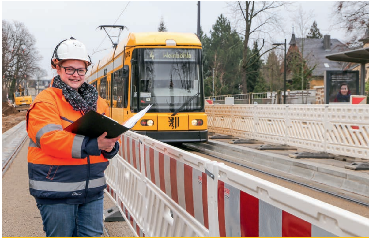
DVB-Bauleiterin Antje Zeibig koordiniert die Arbeiten an den Straßenbahngleisen, an der neuen Haltestelle Zillerstraße und an der Fahrleitungsanlage. Ab Juni können Straßenbahnen und Autos hier wieder ohne Einschränkung fahren.
