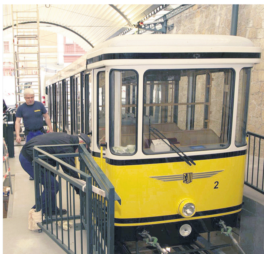
Damit die Standseilbahn pünktlich am 28. Juni 2021 wieder in Betrieb gehen kann, legen die Fahrdienstleiter Roland Hetzer (vorn) und Peter Jankowski im Rahmen der Rekonstruktion selbst mit Hand an.
