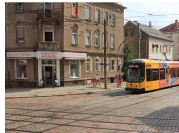
Schienen, Straßen und Leitungen im Bereich der im Volksmund „Schanze“ genannten Kreuzung Pennricher Straße/Rudolf-Renner-Straße sind völlig verschlissen und müssen dringend erneuert werden. Ab März 2014 ist es soweit.
