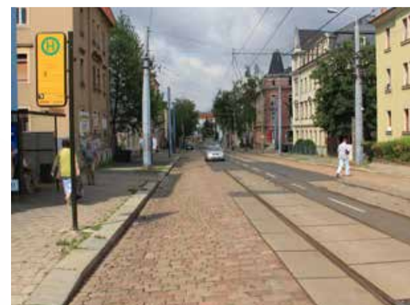
Die Haltestellen „Pennricher Straße“ müssen aus Platzgründen nach dem Umbau zwar mit einem Kompromiss auskommen, ein Großteil der Stationen erhalten aber einen barrierefreien und damit ebenerdigen Zugang.
