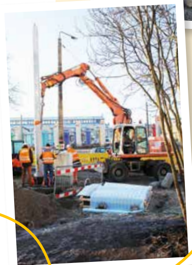
Neuer Mast für die Ladestation am DreyBigplatz
